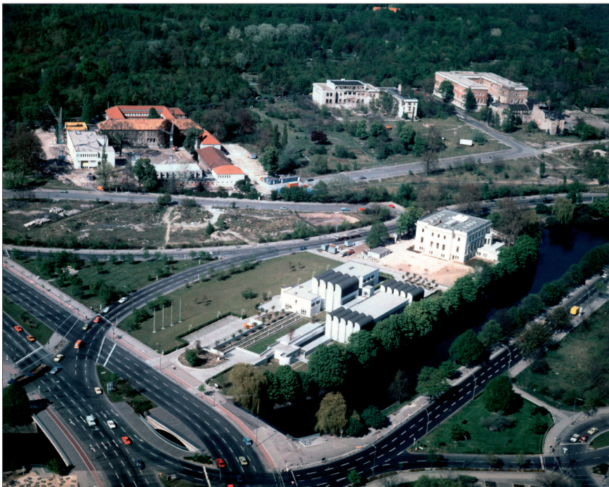
Abb. 08: Luftbild 1979 zur Fertigstellung des Bauhaus-Archivs, rechts die Villa von der Heydt
